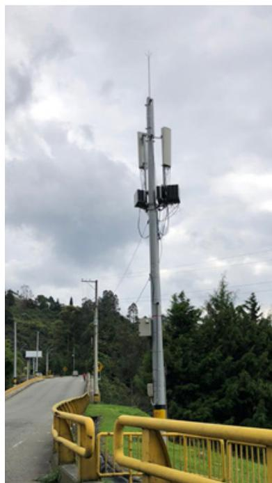
En caso de que no exista ninguna estructura útil para la instalación de antenas dentro del perímetro requerido, se suele proceder a la instalación de los monopolos o de las torres autoportadas sobre suelo<sup>30</sup>, estructuras que deberán contar con una cimentación adecuada para poder resistir las fuerzas a las que estarán sometidas.
