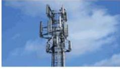
**Sistema de Antena:** Se refiere a la estructura de elevación o soporte de las antenas como torres, mástiles o monopolo y las antenas que sostiene.
